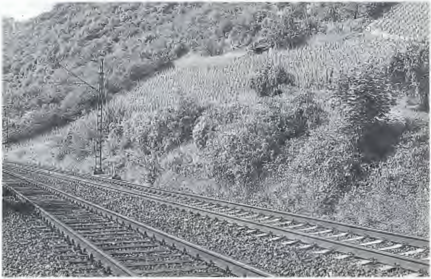
Abb. 2. Probefläche 1 im Mai 1986. Blick aus Süden auf die Böschung. Sample area No. 1 in May 1986. Southern view of the slope.
